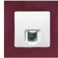
Toma de teléfono
